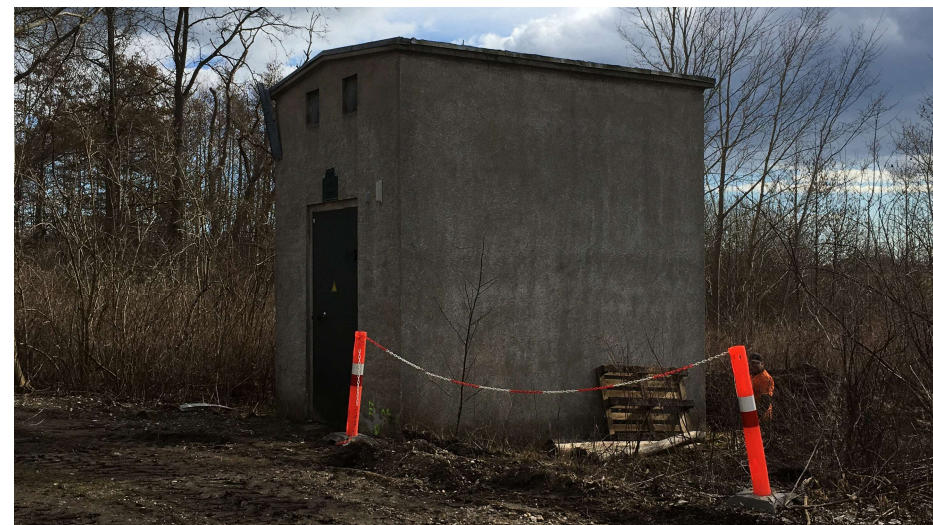
Øv. tv. Olieudskiller, Øv. th. Tavle i Maskinhus 1909, ovenfor Transformerstation. Vignet forrige side: Transformer
