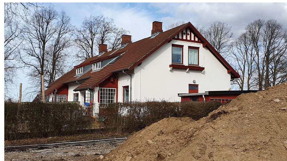
Øv. tv. Frederiksbergboliger, øv. th. Førstemesterbolig, ovenfor Anden og Brøndmesterboliger. Vignet forrige side Anden og brøndmesterbolig:
