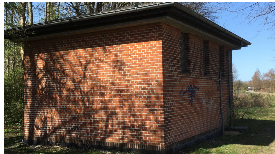
Øv. tv. Tåstrup-Valby pumpehus, øv. th. Havdrup brøndboring, Ovenfor Vallensbæk pumpehus.
