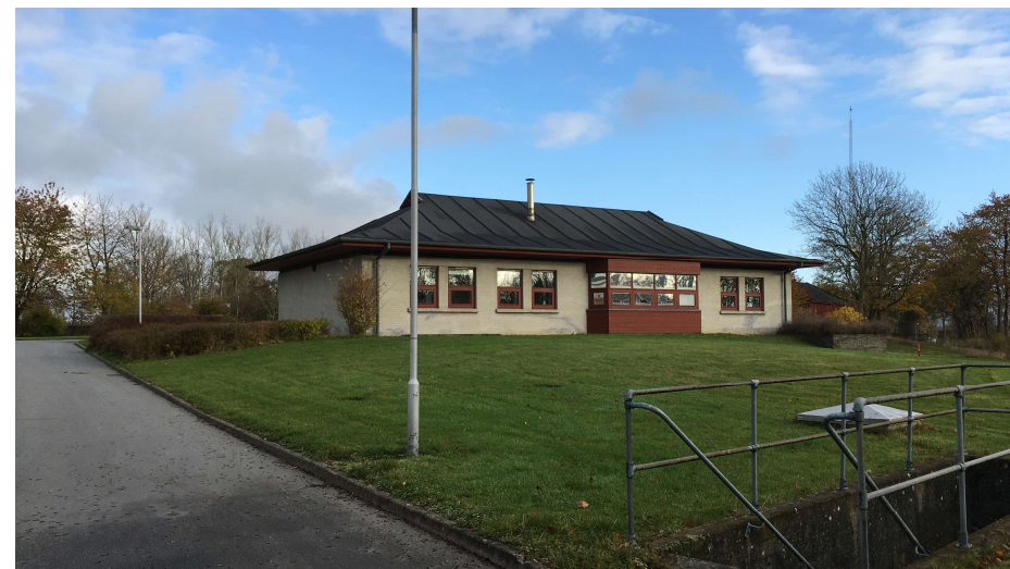
Øv. tv. Baderum Gl. Maskinhus 1908, Øv. th. værksted gl. maskinhus, ovenfor Folkerumsbygning (nedrevet) Vignet fjorrigge side: Værksted gl Maskinhus.
