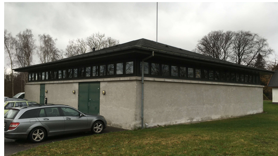
Øv. tv. Trykforøgeranlæg, Øv. th. målerbygværk, ovenfor Maskinhus 1985. Vignet forrige side: Maskinhus 1908
