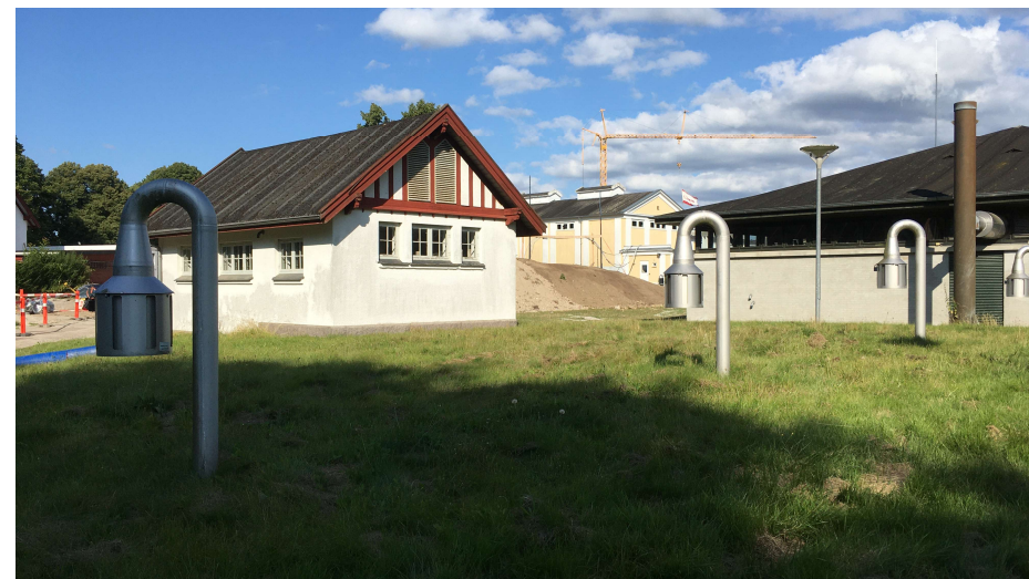
Øv. tv Samlebrønd, Øv.th. tunnel, Rentvandsreservoir under jorden foran Hanekammerbygning.
