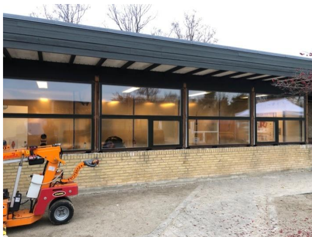
Efter - foto af nye vinduer på Vibeholmskolen
