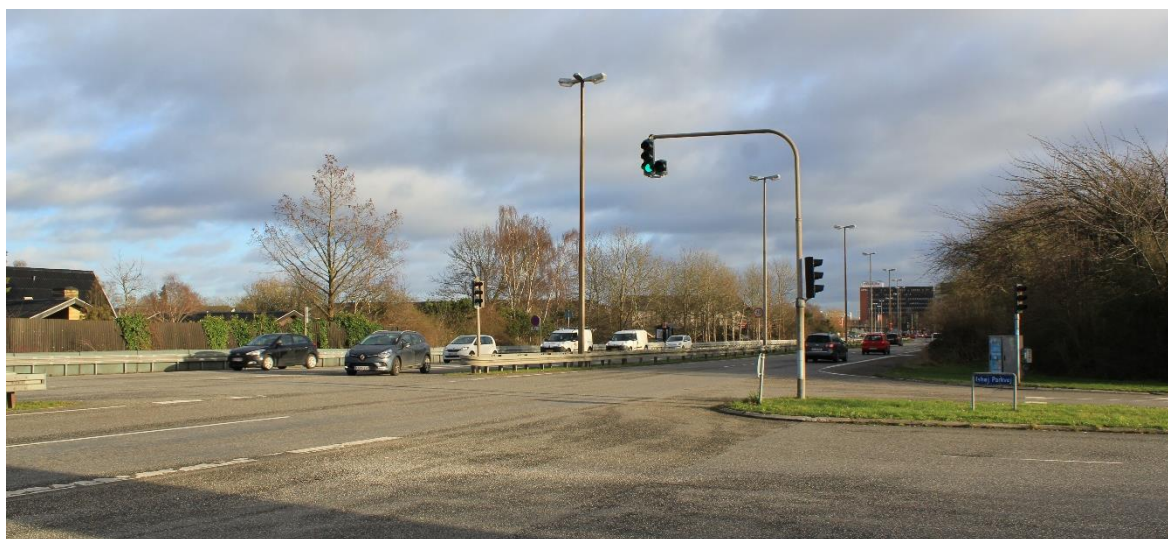
Figur 33: Ishøj Stationsvej set mod SØ
