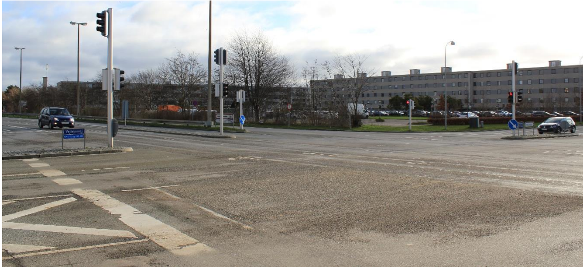
Figur 24: Billede taget ved besigtigelse af krydset. Ishøj Stationsvej set mod SØ
