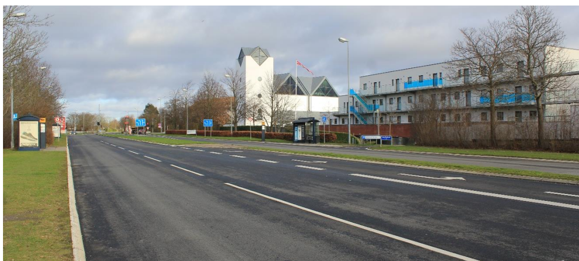
Figur 29: Billede fra besigtigelse. Ishøj Boulevard set mod NØ
