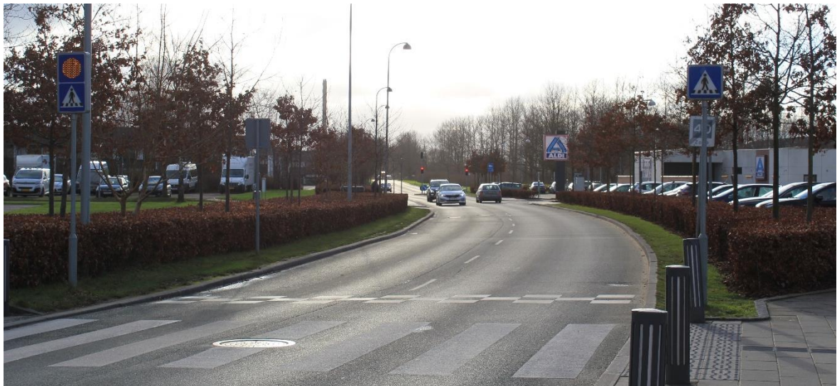
Figur 26: Billede fra besigtigelse. Vejlebrovej syd for Ishøj Stationsvej set mod SV
