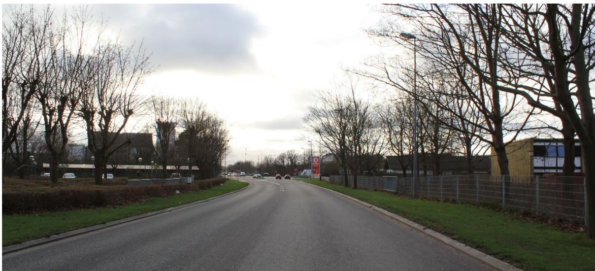
Figur 31: Billede fra besigtigelse. Vildtbanevej set mod SV
