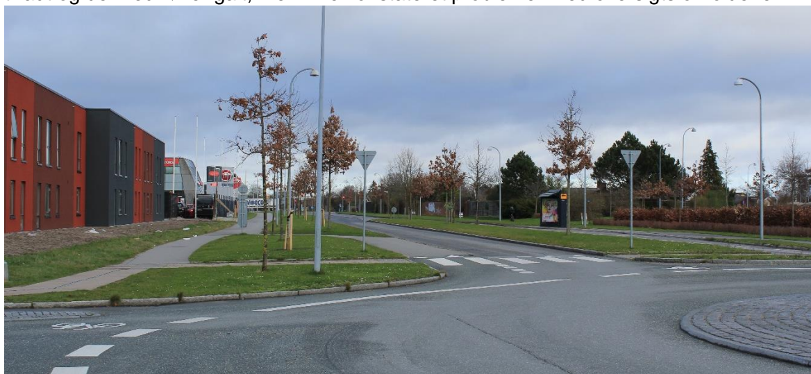
Figur 20: Billede taget ved besigtigelse af krydset. Ishøj Strandvej set mod NØ
