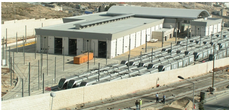
Figur 3-28 | Eksempel på kontrol- og vedligeholdelsescenter til letbanen (Jerusalem).
