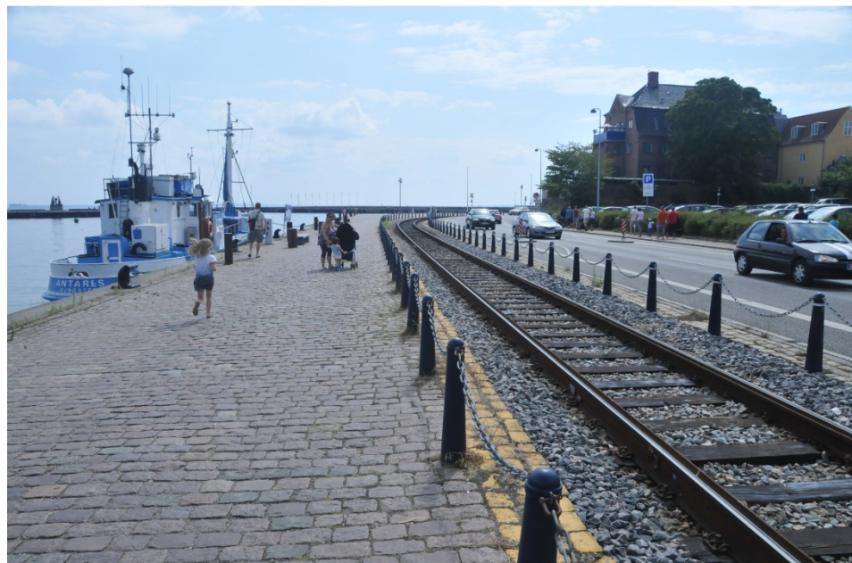
Figur 3-24 | Eksempel på ballasterede spor, som anvendes på hovedparten af letbanen på Ring 3.
