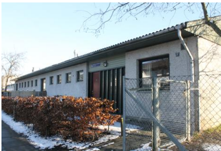
Den eksisterende institution 'Musvitten' der skal nedrives
