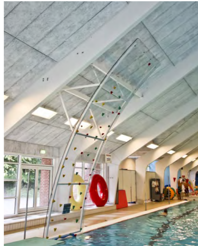
Klatrevæg, Tønder Svømmehal
