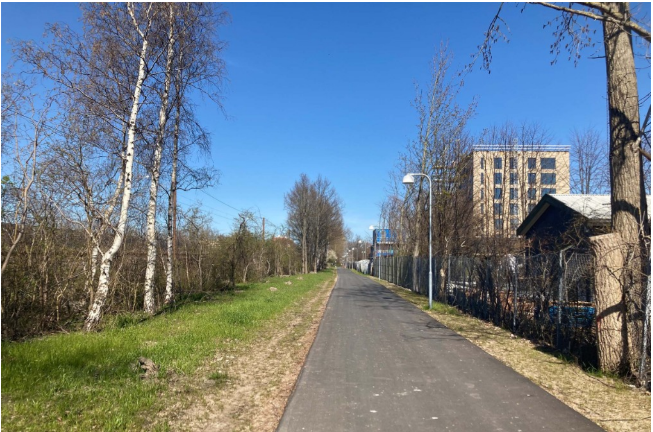
Banestien forbinder området til Ishøj Station samt Ishøj Bycenter
