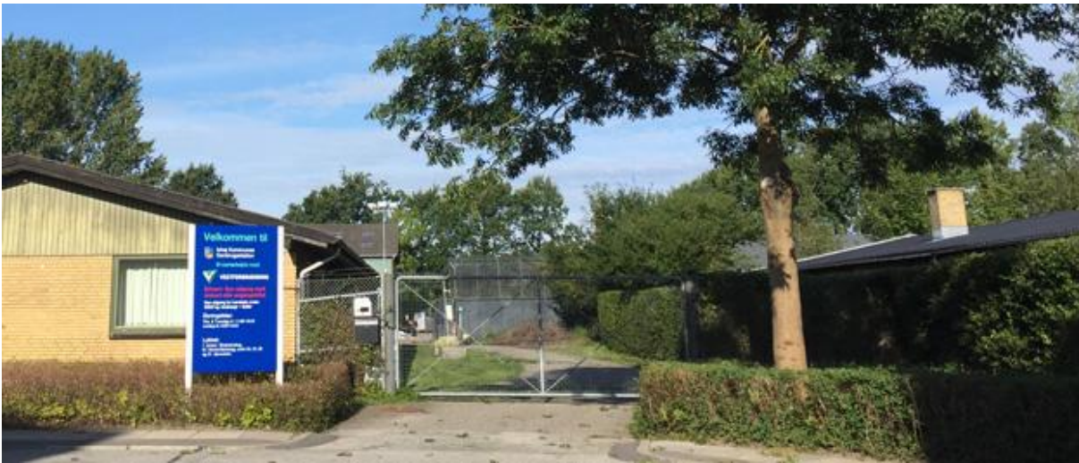
Indgang til Genbrugsstationen og Varmeværkets administrationsbygning. Varmeværkets skorsten rager op i baggrunden.
