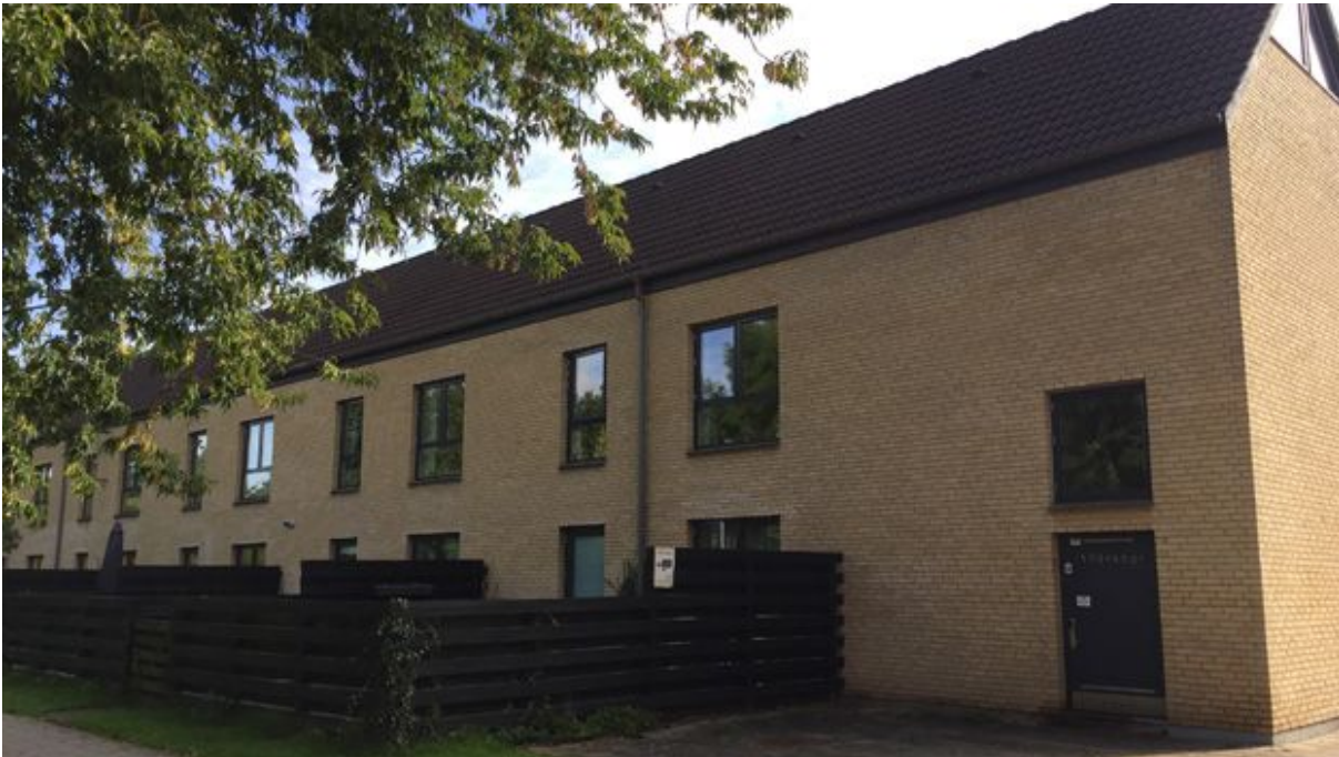
Omsorgscentret Kærbos plejeboliger med haver der ligger ud mod lokalplanområdet.
