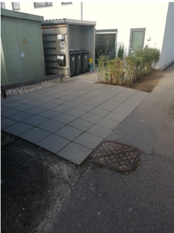
Der etableres aquadræn langs hele det flisebelagte areal
