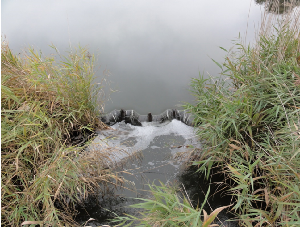
Figur 7. Spunsvæggen der adskiller lagunen ved Store Vejle Å's udløb (øverst i billedet) med Jægersø (nederst i billedet). Den nedskårne strækning udgør 11 meter.
