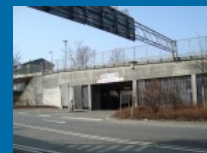
Indkørsel til parkeringshallen fra Ishøj Centervej.
