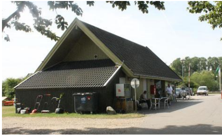
Receptionsbygningens nordlige gavl med forpagterbolig på 9 m 2 oppe under taget.
