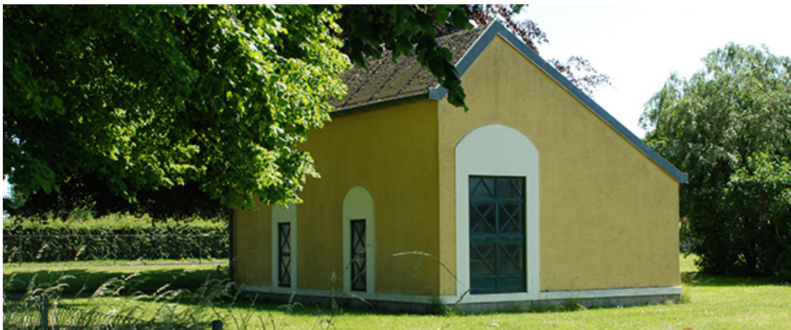
Eksisterende pumpestation ved Allévej.
