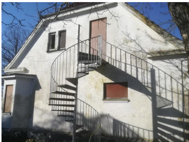
1.5 Bygningens facade mod øst
