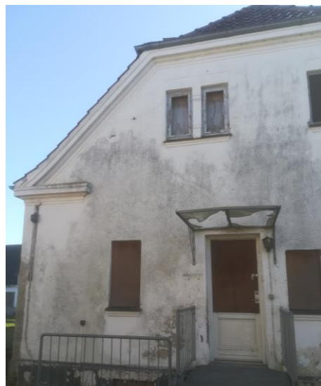
1.6 Bygningens facade mod vest
