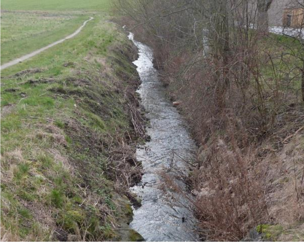
Figur 16: Strækningen syd for overkørslen ved Torslundevej
