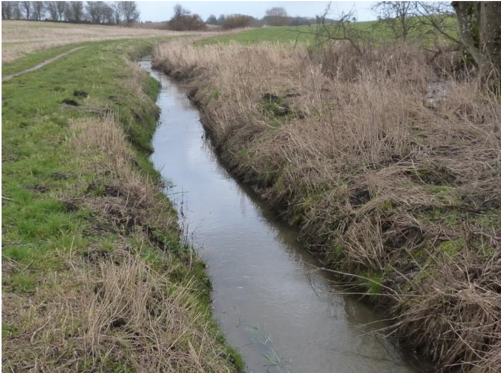
Figur 17: Strækningen opstrøms betonbelægningen i Ishøj Kommune
