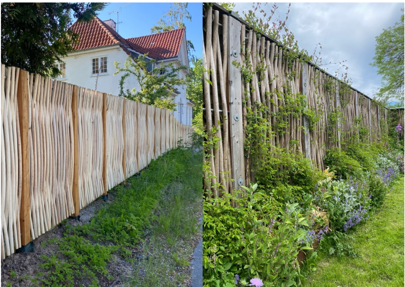
Støjværn med og uden beplantning.
