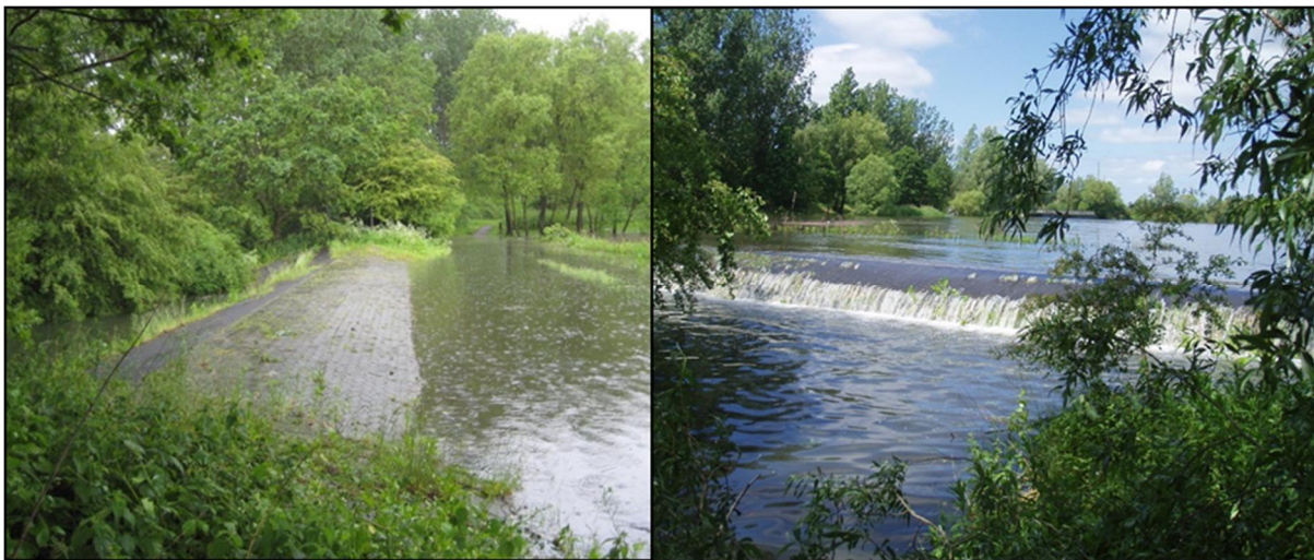
Figur 4. Eksisterende nødoverløb ved Vallensbæk Sø, i funktion ved hændelsen fra 2009
