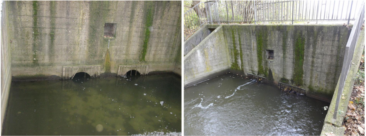
Figur 5. Udløb fra Vallensbæk sø. 2 stk. Ø800 mm ventiler
