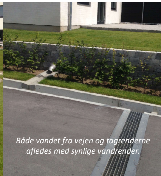
LAR-løsning (lokal afledning af regnvand) ved Kirkebjerggårdsvej i form af vandrender som løber ud i et regnvandsbassin.
