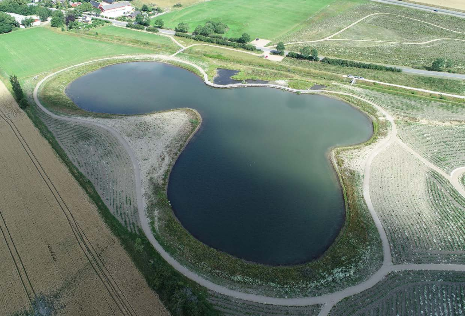
Den nyetablerede sø i Landsbyskoven fungerer som forsinkelsesbassin ved store regnhændelser.
