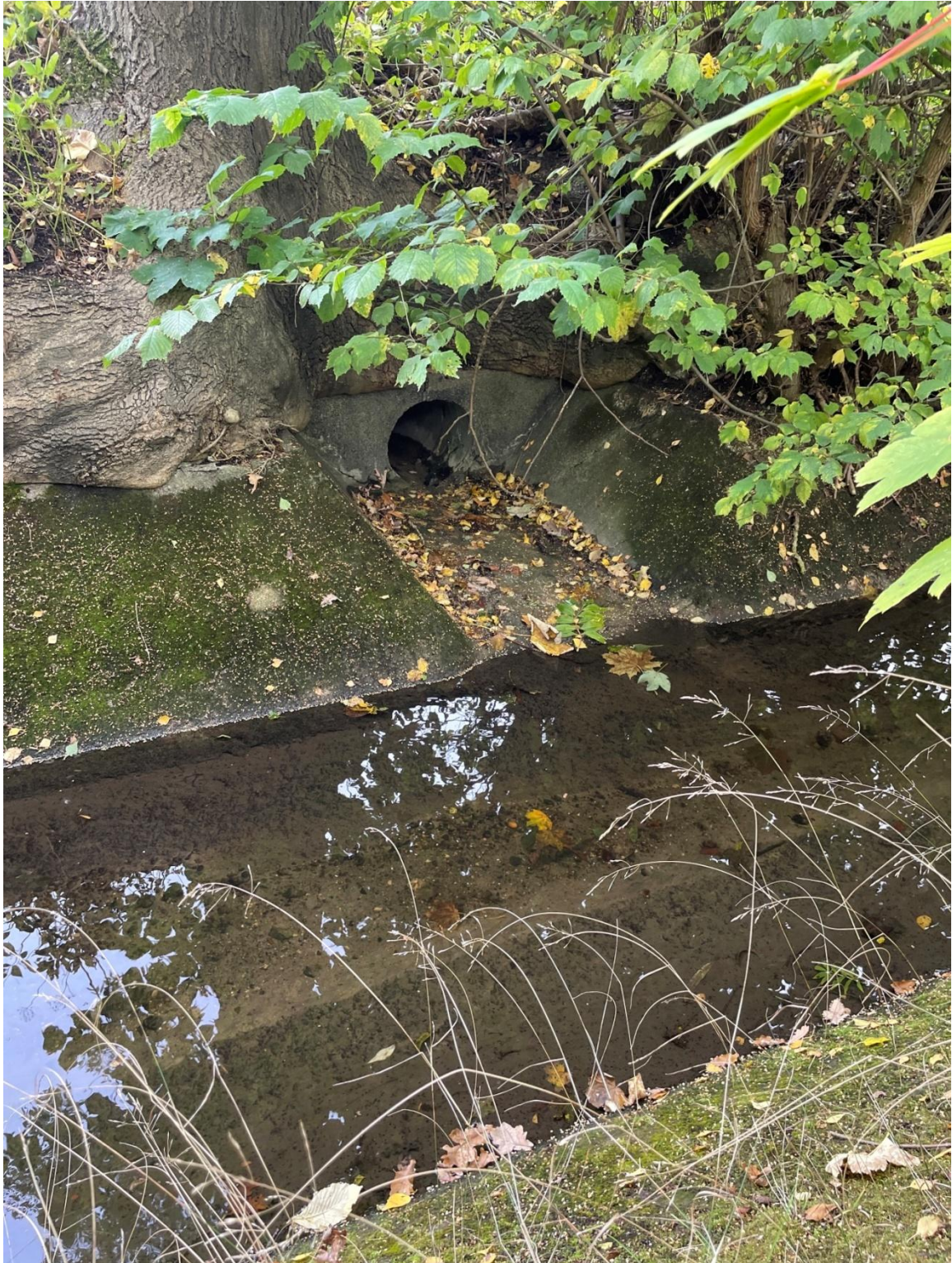
Udløbsbygværk med koordinaterne N: 6168867.17, E: 705901.143
