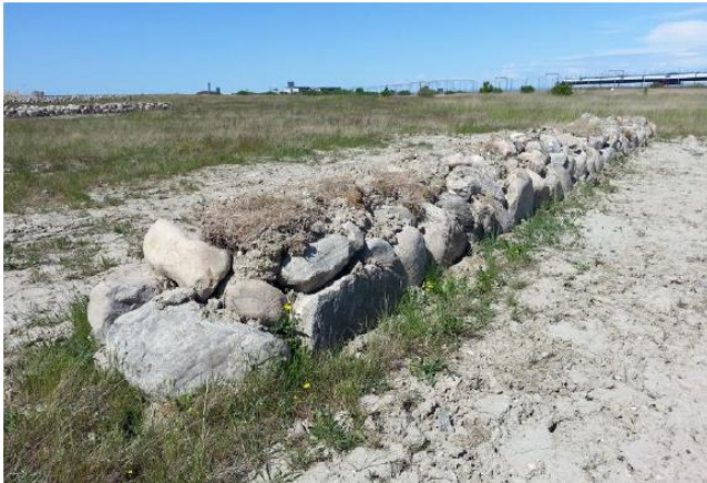
6). T.v. stendige med græstørv på toppen, Kastrup Lufthavn. I dette projekt bliver toppen også af sten, og ikke tørv som vist på billedet. T.h. principskitse af tværsnit af stenbunke/stendige.
