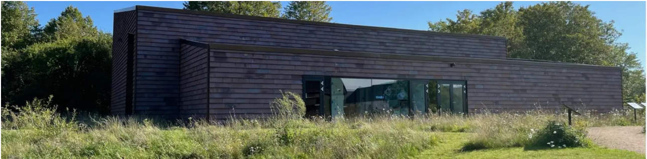
Ishøj Vandværk vinder arkitekturpris. Foto: Ishøj Kommune
