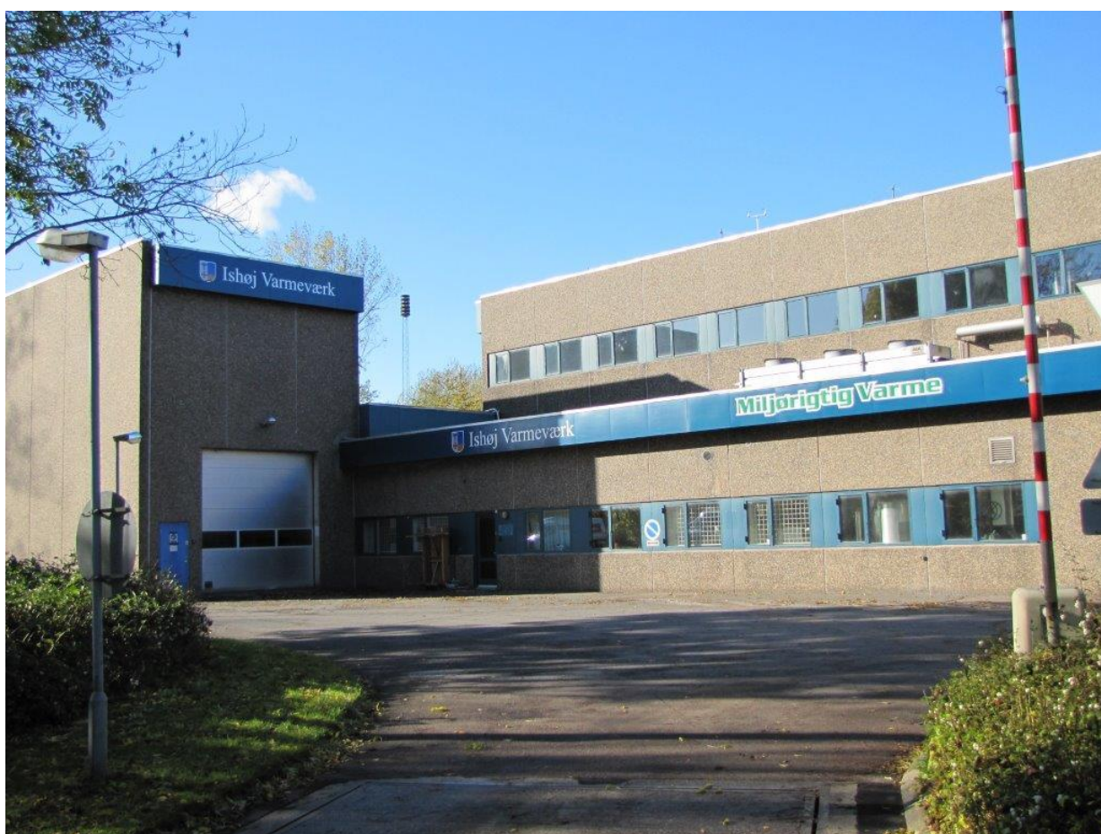
Foto : Indkørsel til Ishøj Vanneværk
