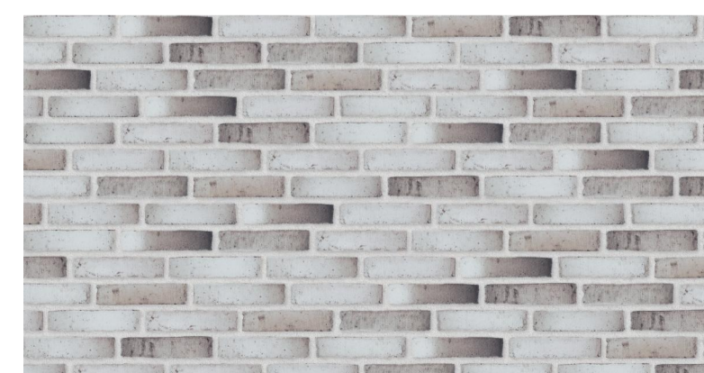
Udsnit af murede facader: Blank mur stentype: blødstrøgen engoberet sten RT 546 Unika m. lys fuger
