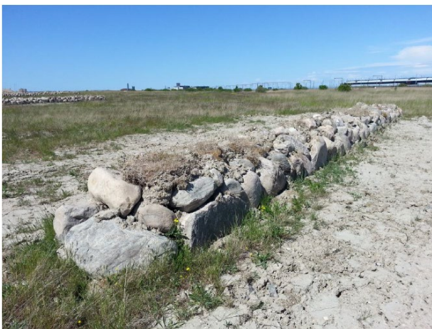
Figur 4. T.v. stendige med græstørv på toppen, Kastrup Lufthavn. OBS. i dette projekt skal der være sten, og ikke tørv på toppen af stendigerne. T.h. principskitse af stenbunke/stendige (tværsnit)
