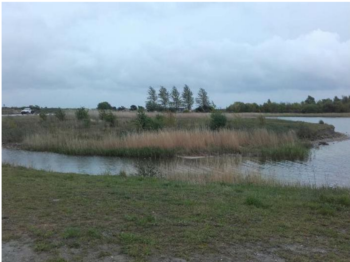
Foto 6. Gangbroen krydser her vandsiden til holmen. Broen har en højde der skal sikre færdsel i kajak under broen.
