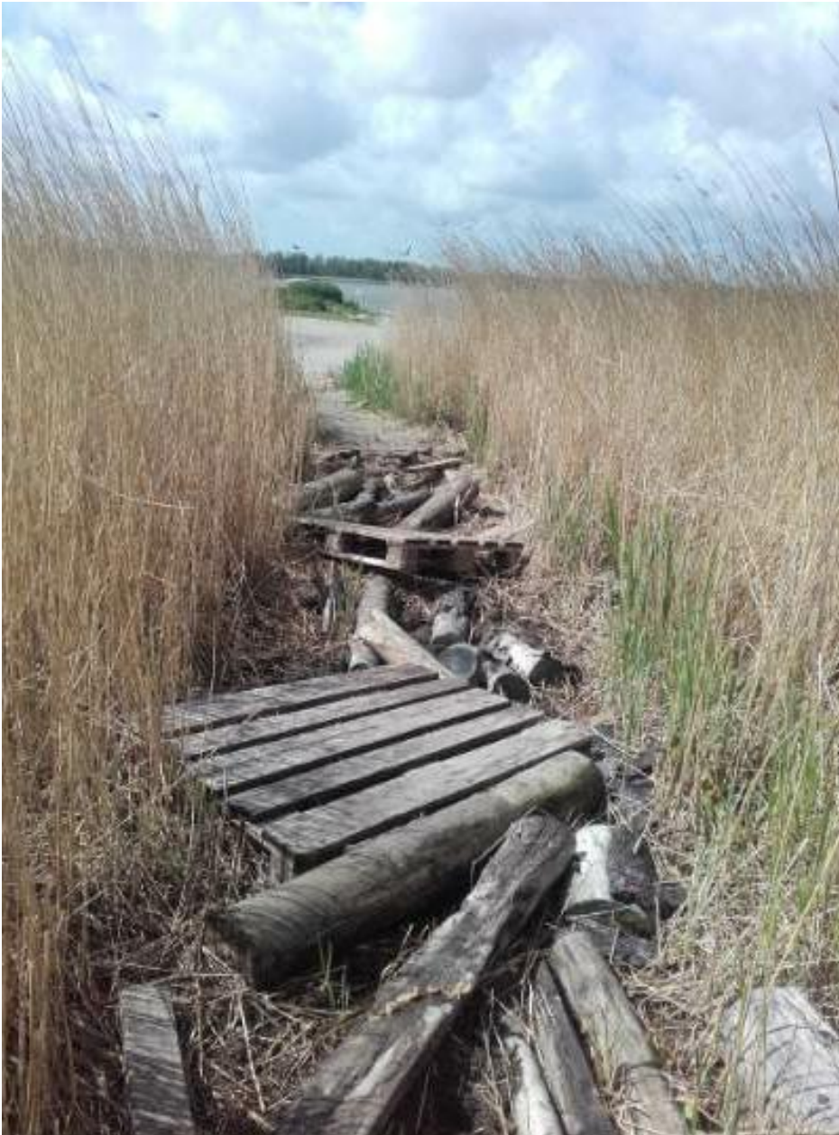
Foto 2. Selvbestaltet adgang til fugleø. Tømmer og paller fjernes og i stedet anlægges en ny træbro syd for, som vil give kig ud over søen.
