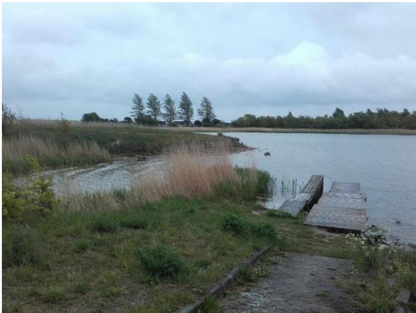
Foto 5. Gangbroen krydser landsiden ved nedgangen til slæbestedet, og broen øges en anelse i højden, når den igen krydser vandet for så at slutte til et stykke inde på holmen.
