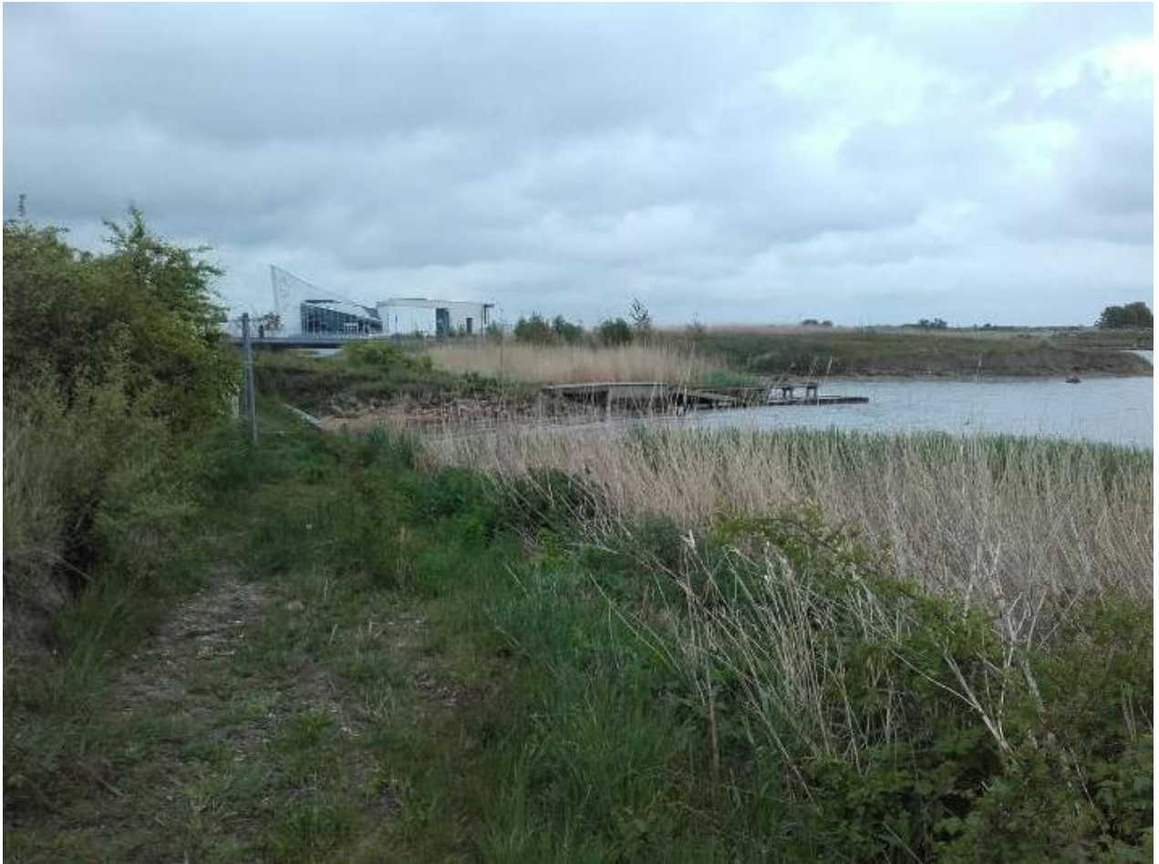
Foto 3. Gangbro 2 etableres med start fra landsiden. Broen er i alt 78 meter. På det første stykke følger broen terrænet og bugter sig over vandet med en sikkerhedsafstand på minimum tre meter til slusebygværket.
